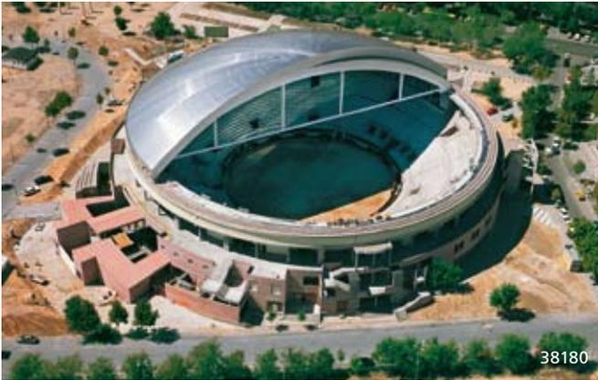
Schutz gegen Sonne oder Regen: Die Kuppelhälften können, je nach Bedarf, sanft in Position gedreht werden.
