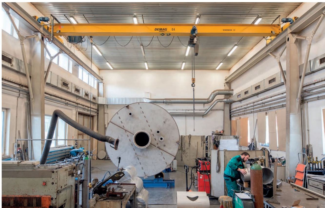
Hala pro zpracování nerezové oceli disponuje jeřábem DEMAG s nosností 5 tun
